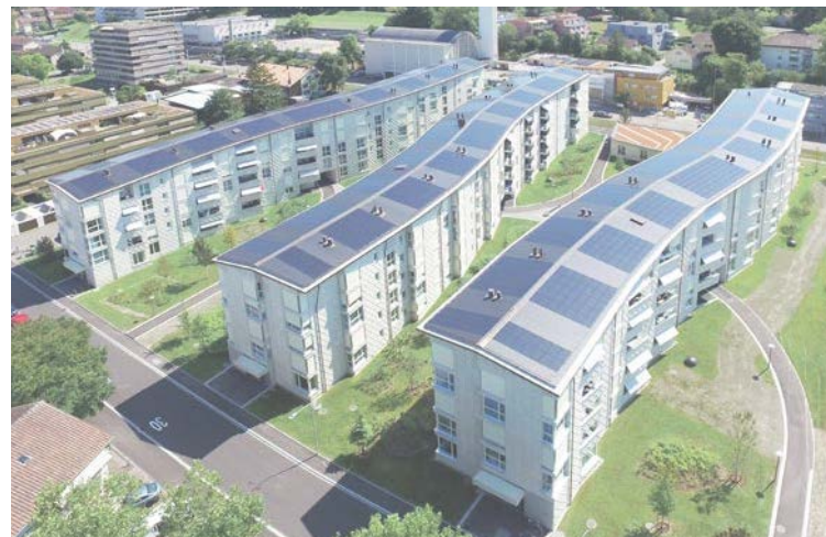
Im Schuppis I: Die erste Ersatzneubau-Etappe des Schwamendinger Dreiecks wurde im Minergie -P ® -Baustandard erstellt und 2019 bezogen.
