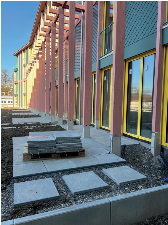
Die Steinplatten für die Sitzplätze der Parterrewohnungen werden verlegt.
