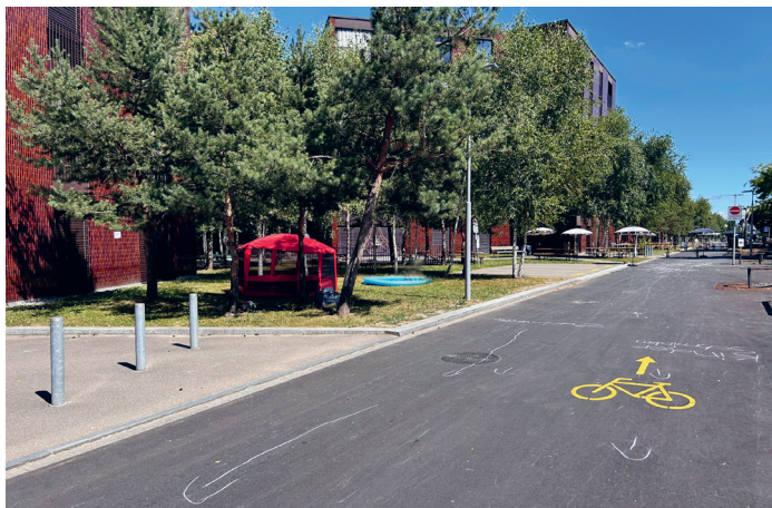
Die neugeschaffene Begegnungszone in der Katzenbachstrasse.
